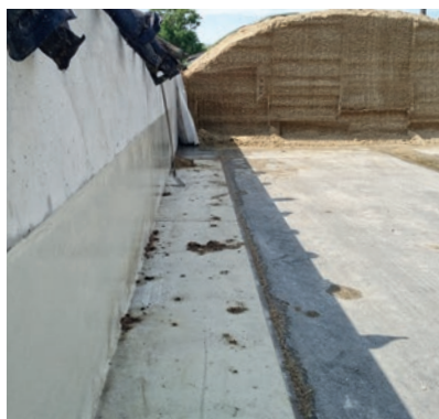
Silážní žlaby Kyselá prosakující silážní štáva rozkládá silážní žlab ve velmi krátké době. Produkt MC-PowerPro HCR se postará o dlouhou životnost.
