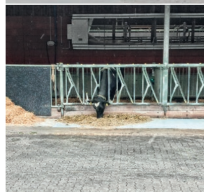
Krmné stoly Krmiva působí agresivně na beton. Produkt MC-DUR TopSpeed před- stavuje rychlé a odolné řešení při nanesení ochranné vrstvy.
