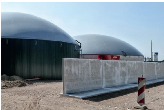
Bioplynová stanice Při fermentaci působí silně agresivní média na beton. Produkt MC-PowerPro HCR chrání spolehlivě.
